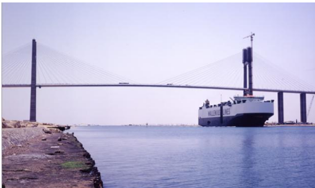
スエズ運河橋 (エジプト2001年竣工)
